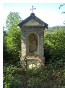
Pilone del depuratore
